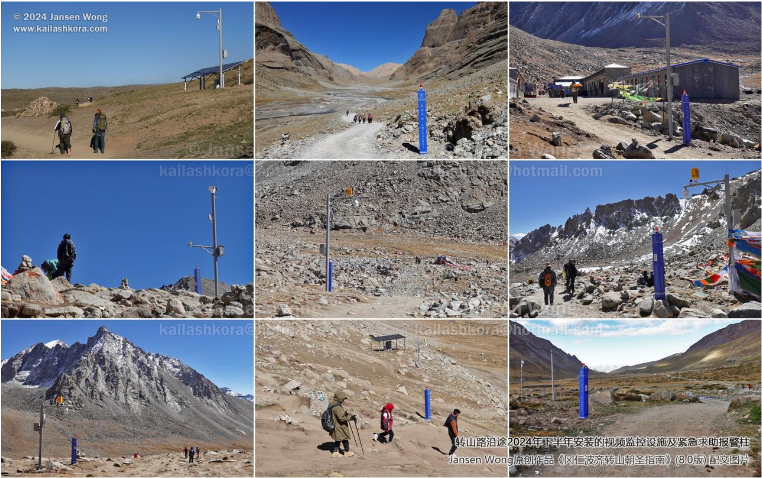
▲转山路沿途 2024 年下半年安装的视频监控设施及紧急求助报警柱
