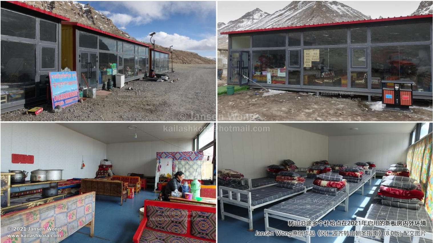
▲转山沿途补给点在 2021 年启用的新板房内外环境
